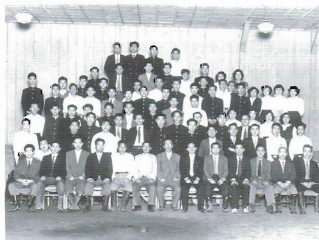
昭和29年 ノコギリ校舎時代 雨漏りのする講堂 足もとに注目
